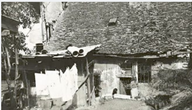
Logement insalubre à Chartres, rue de la Corroierie, en 1946 (archives C'Chartres habitat).
