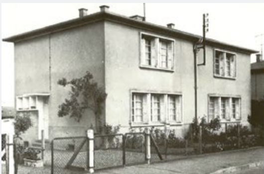
La première pierre du programme Rechèvres 44 est posée en 1947. 19 bâtiments comptant 44 logements sont livrés en 1949.
